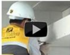
[Video] Hướng dẫn thi công trần chìm giặt cấp hồ
